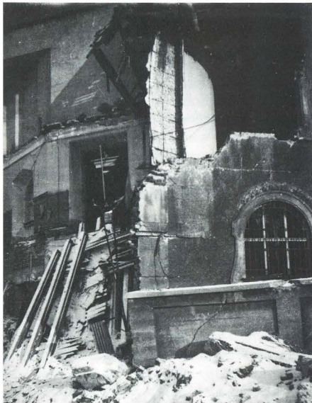
Nach dem Luftangriff vom 4. Oktober 1944, die zerstörte Theresienkapelle
