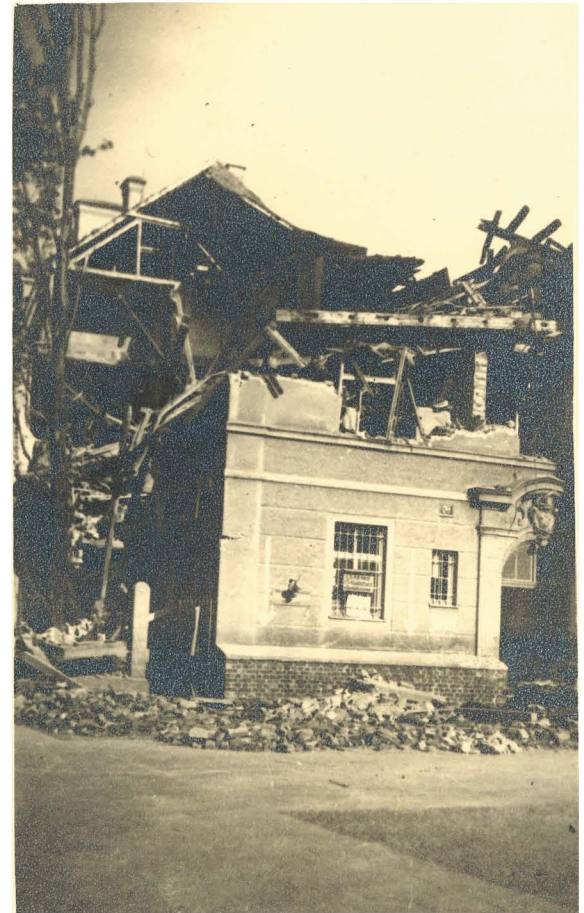
Nach dem Luftangriff vom 21. April 1945, der zerstörte Pfortentrakt des Klosters
